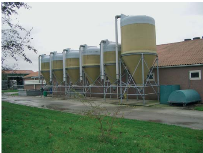
Figuur 2.14 Pluimvee- en veehouderijen bewaren het krachtvoer in silo's.
